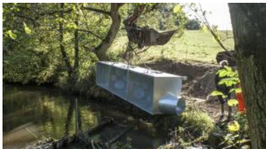
Figur 9: indløbskasse til indløb til Hvilested Dambrug ved Kolding Å/Vester Nebel Å.
